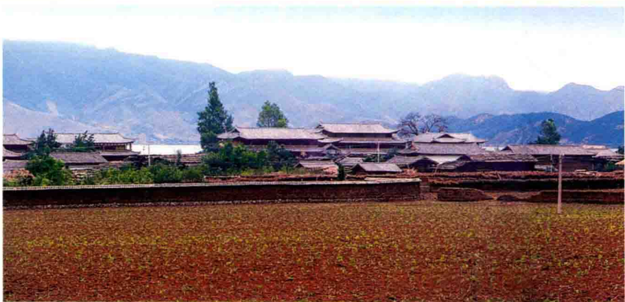
图1-5 洛水下村全景（杨大禹 摄）
