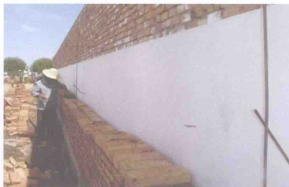
彩图16 温室保温后墙建造
