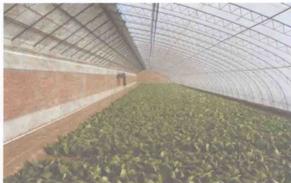
彩图14 全钢架无支柱日光温室
