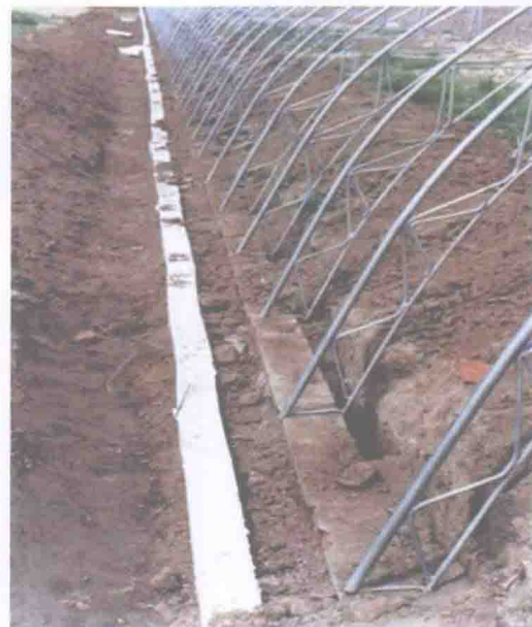
彩图35 温室建造防寒沟
