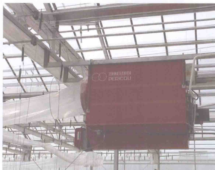
彩图23 温室柴油热风加温设备
