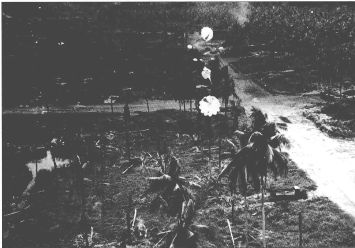
B-25低空轰炸日军野战机场时，由于飞行高度很低，为了防止被炸弹误伤，因此在炸弹尾部系上降落伞，延长炸弹滞空时间。
