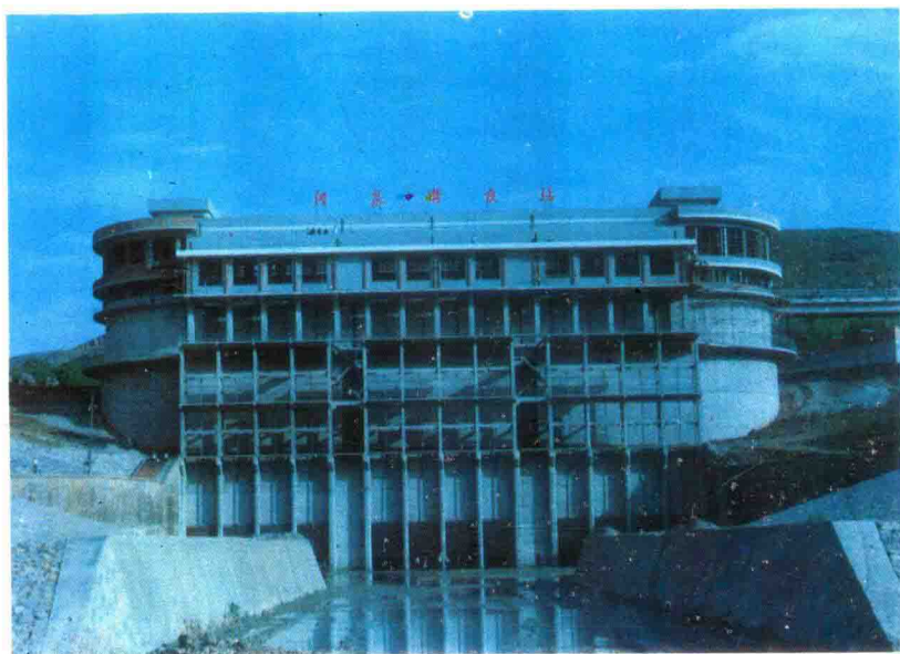
◁ 建设银行老河口市支行支持建设的清泉沟泵站全景。
