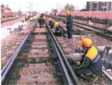
4. 起道找平：先起标准股，后起对面股，道尺尽可能靠近起道机，看道人回看纵向水平，视高低情况补撬
