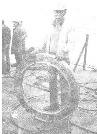
圖 1-3-a 樁墊使用三夾板之情形
