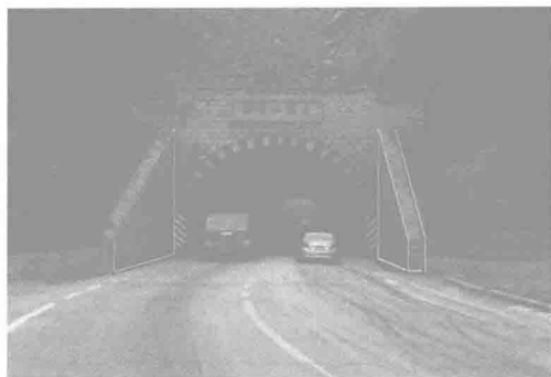
b)翼墙式洞门
