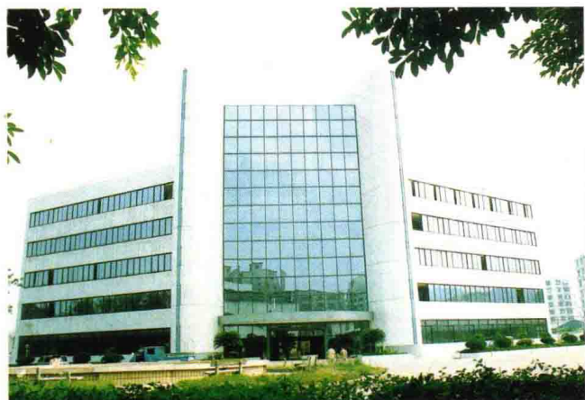
重庆汽车制造厂轻型车技术开发中心 荣获重庆市建筑工程鲁班奖
