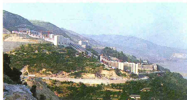
建设中的奉节新县城
