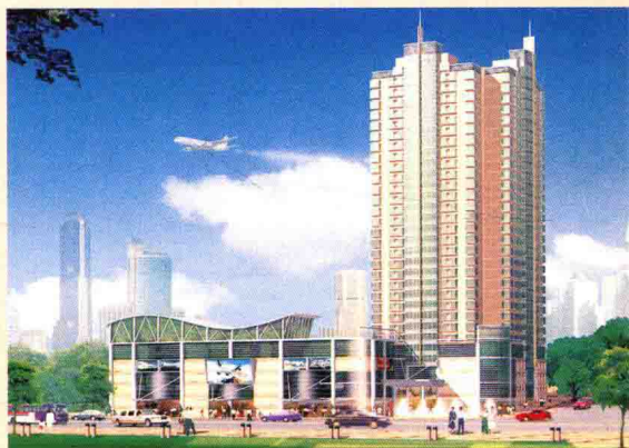
民航重庆市局货运综合大楼
