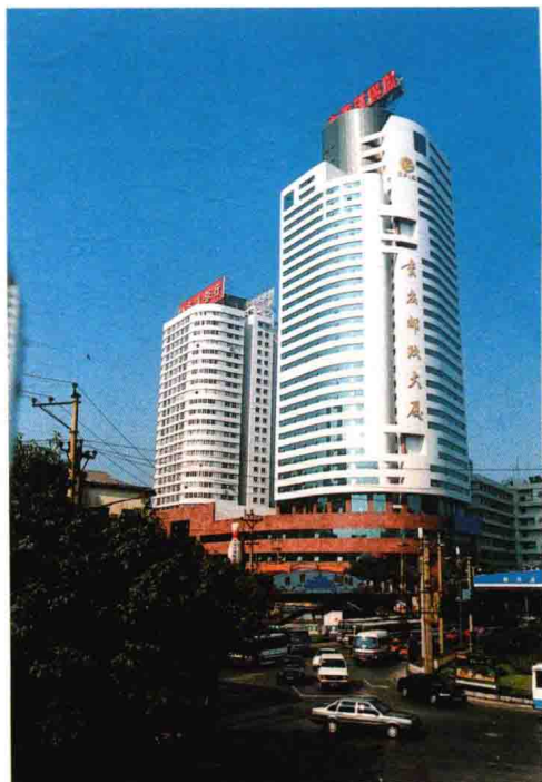
重庆太平洋广场、邮政大厦 荣获重庆市建筑工程巴渝奖
