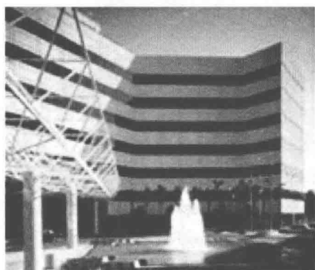
图 1-6 南加州大学医院（基础隔震结构）
