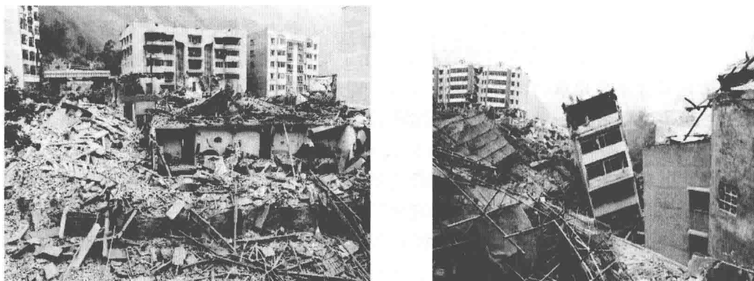
图 1-1 汶川地震中被破坏的房屋建筑
