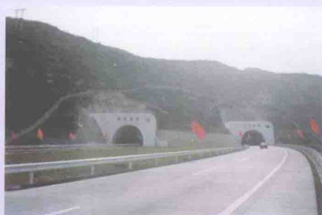
马万水分公司建设的山西太旧高速公路北茹隧道获得国家鲁班奖
