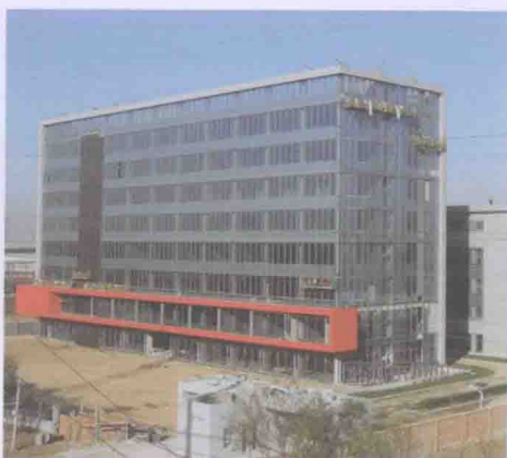
贺延素所在的中国华冶二建分公司项目部承建的北京四环制药工程获得北京市结构“长城杯”“国家 AAA 级安全文明工地”称号
