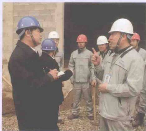
中国华冶集团二建北京四环制药项目经理贺延素（右）向全国人大代表孙东林介绍北京四环制药工地项目管理情况
