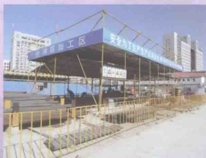
建设中的天津柴楼庄园
