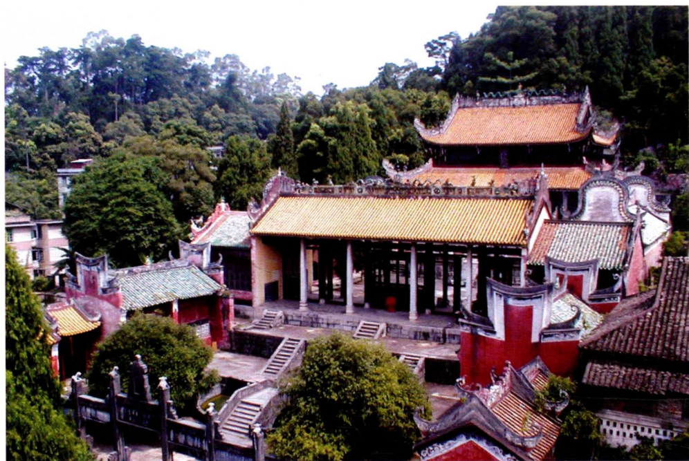
广西恭城古建筑群——文庙全景
