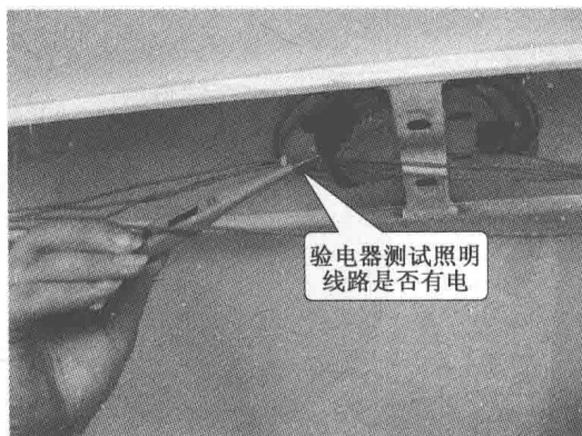
图 1-4 验电器测试用电线路是否有电
