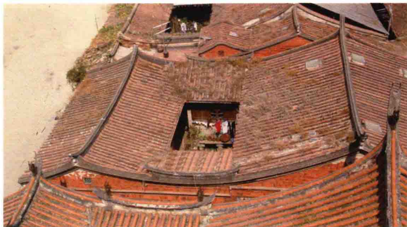
图 1-1-05 下落、顶落与榫头
