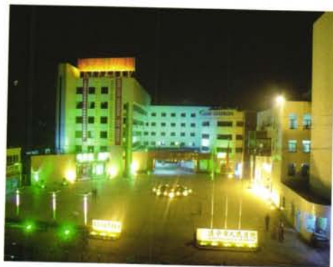
门诊大楼(建于1991年)
