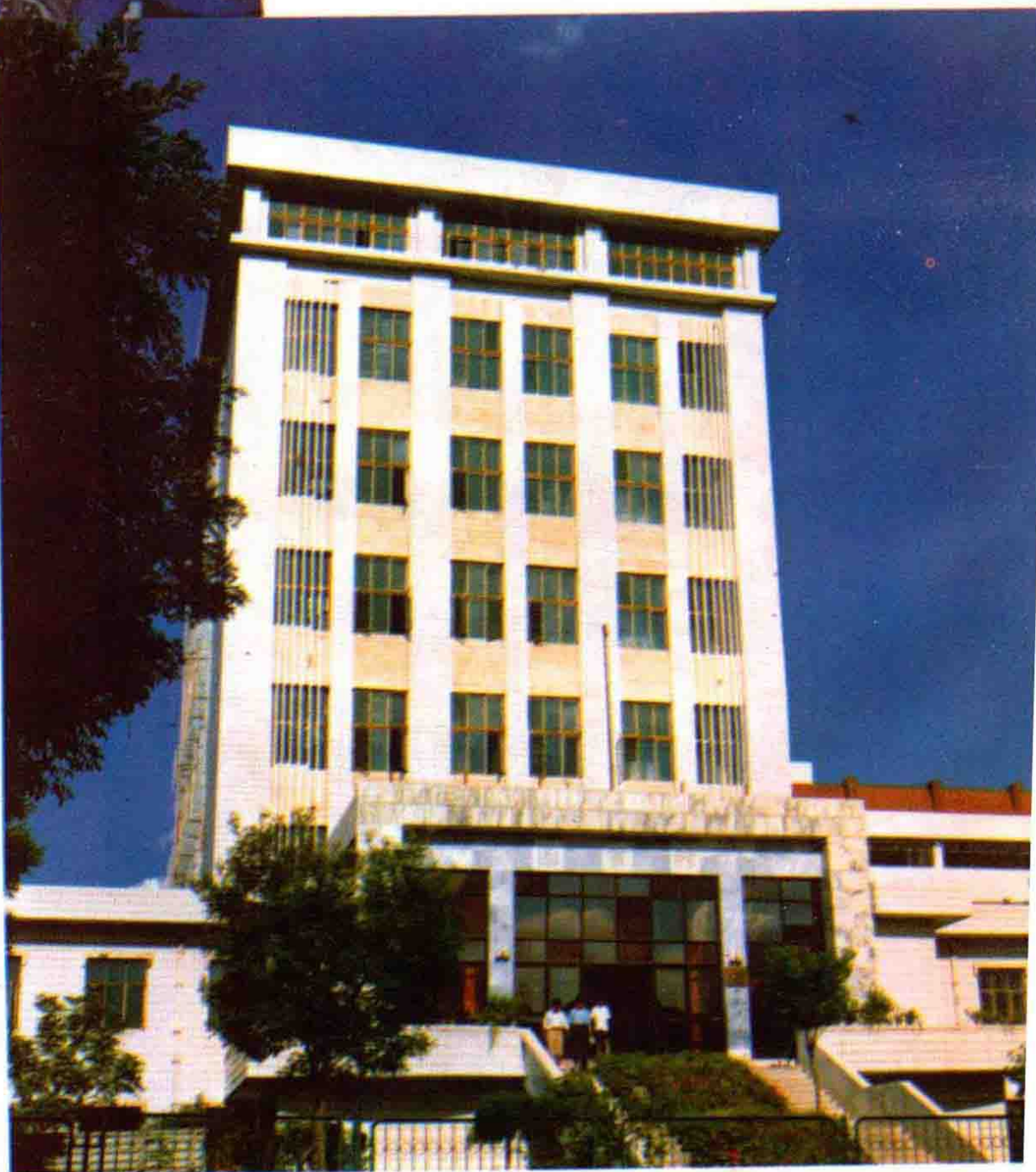
承德石 油高等技术 专科学校图 书馆大楼
