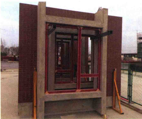
图 1-6 面砖反打和窗框集成
