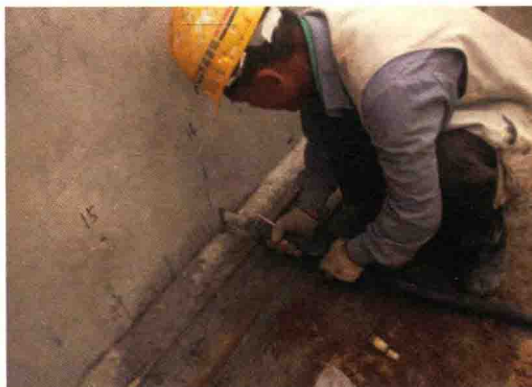
图 1-12 灌浆套筒和灌浆施工
