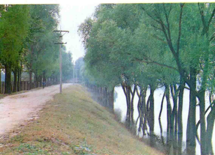
△马颊河陵县段马才堤防
