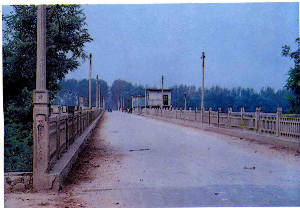
△漳卫新河陵县袁桥公路桥
