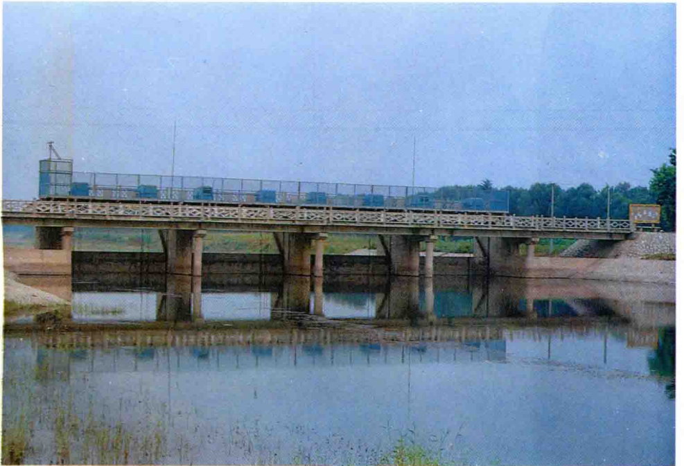
△马颊河陵县马才（新河）拦河闸
