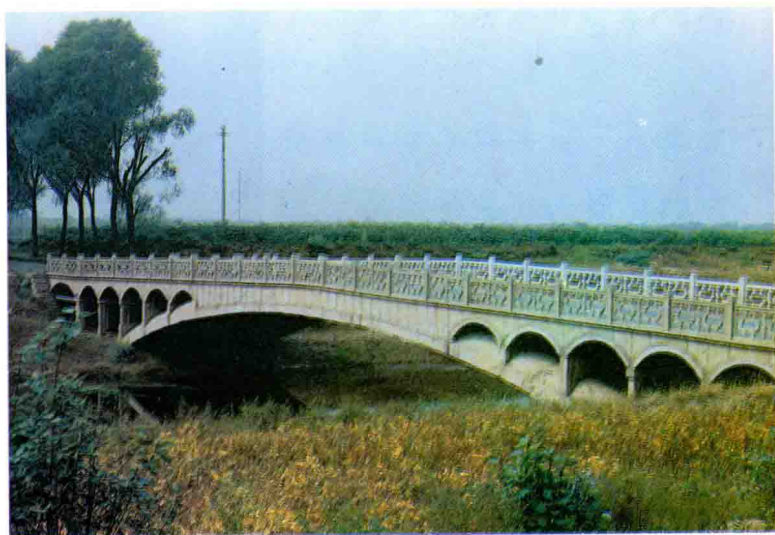
△杨庄河冯家寨双曲拱德宁公路桥
