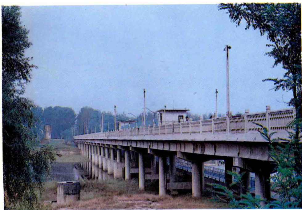
△漳卫新河陵县袁桥拦河闸
