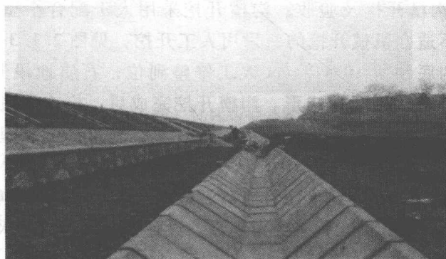
图 2.1.1 混凝土预制块排水沟
