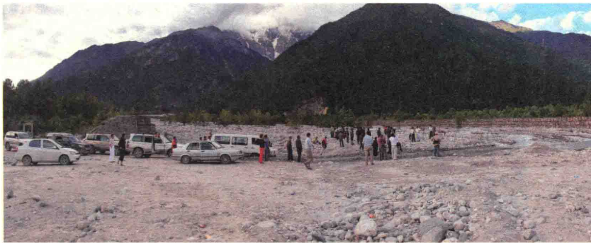
古乡沟泥石流造成川藏公路被阻断
