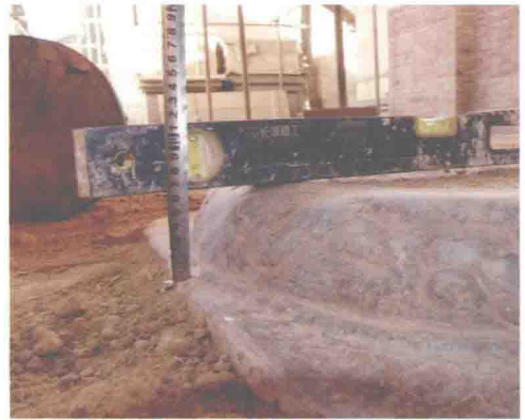
4-2 前檐明间西侧础石：础盘高 65 毫米，雕饰为行龙
