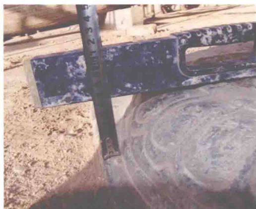
1-3 前檐东角柱础石: 覆盆高 65 毫米, 立面雕饰为铺地莲瓣
