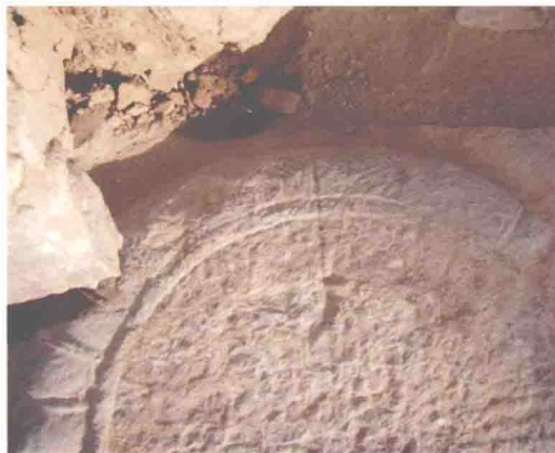
1-2 前檐东角柱础石: 北侧为毛面
