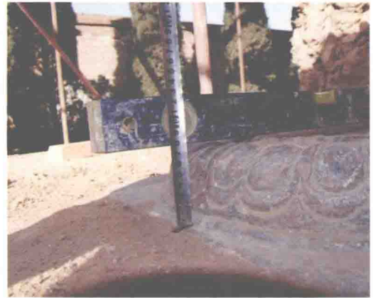
5-2 前檐西梢间东侧础石：础盘高 80 毫米，雕饰铺地莲瓣
