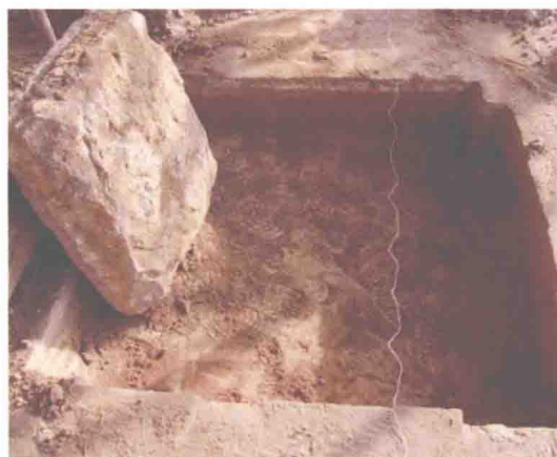
1-4 前檐东角柱础石: 础石底面毛面, 直接坐落于土台上
