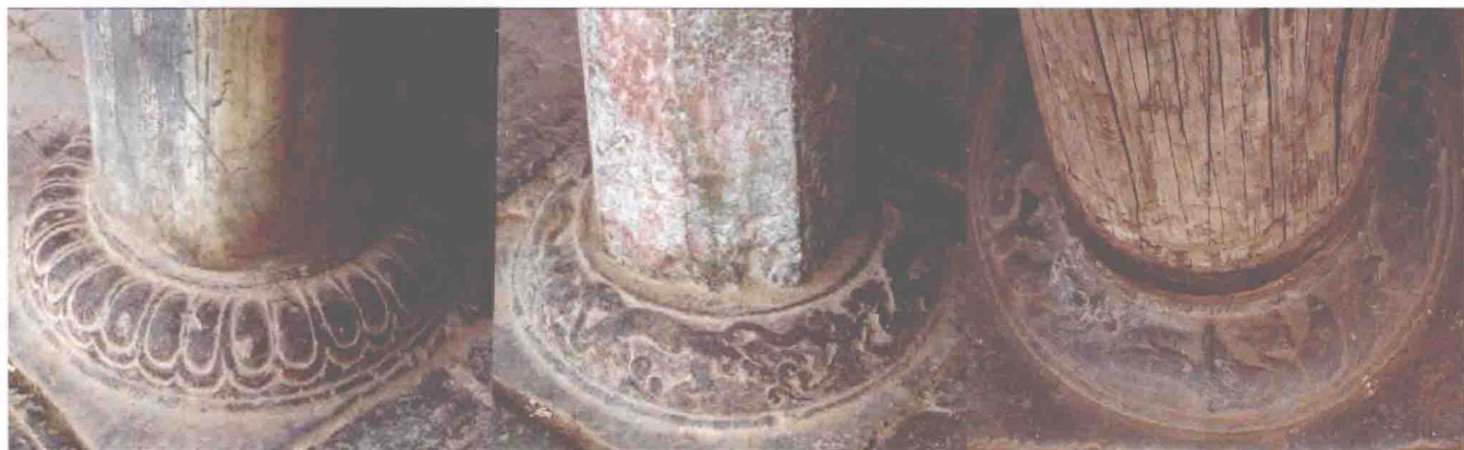
图 3-1-1 稷王庙大殿重修前檐檐柱下的三种覆盆柱础雕饰：莲瓣、龙纹和凤纹（左图为修缮前，前檐西梢间东柱下的莲瓣柱础，修缮后，该柱础调换至前檐西角柱下）
