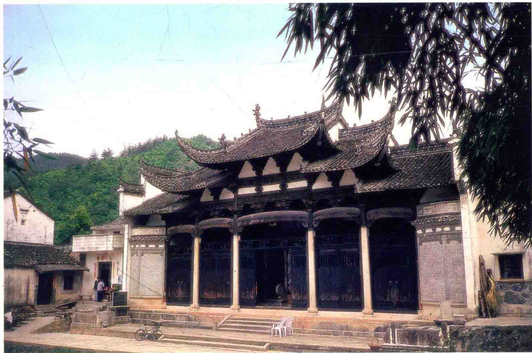
图1-2 徽州祠堂的大门 一般建成翼角高耸的五凤楼。
