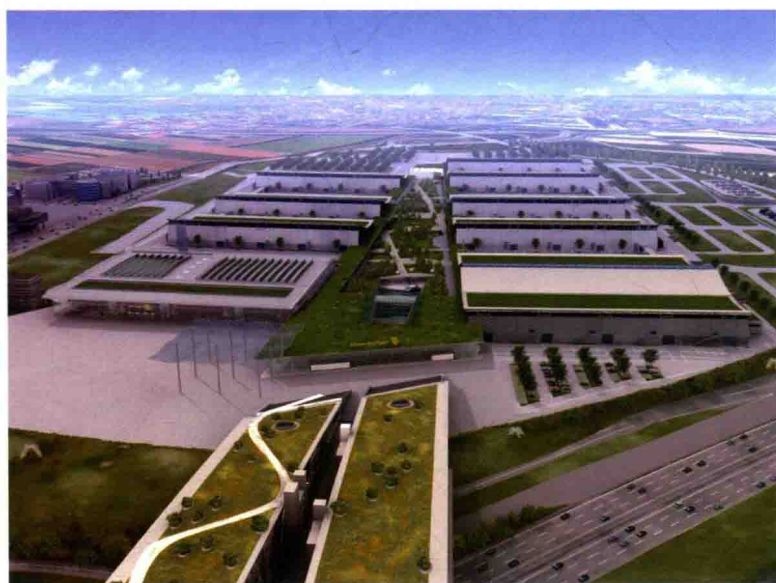
按照词的本义所看到的公园般的景色：斯图加特新博览会的博世停车楼 建筑师：Wulf建筑事务所，照片：©斯图加特博览会
