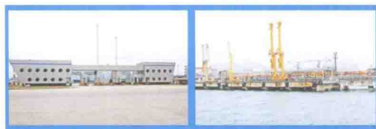
■ 惠州港通用码头东部新大门 ■ 惠州港油气码头
