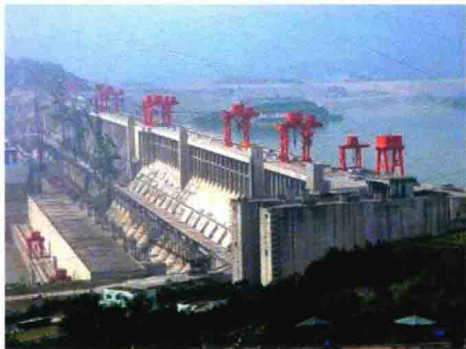
三峡大坝，世界上规模最大的混凝土重力坝。
