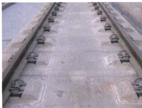
图 1-11 CRTS II 型轨道系统结构
