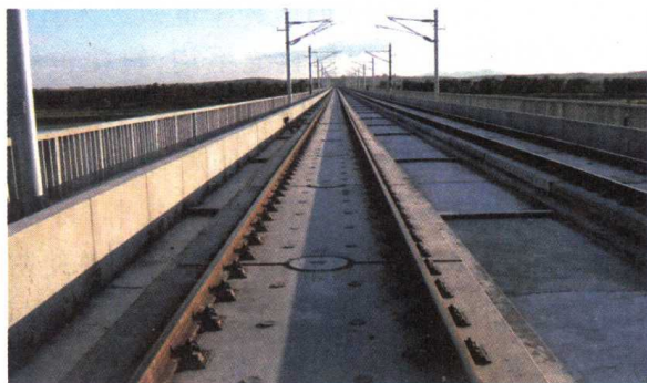
图 1-10 CRTS II 型轨道系统结构
