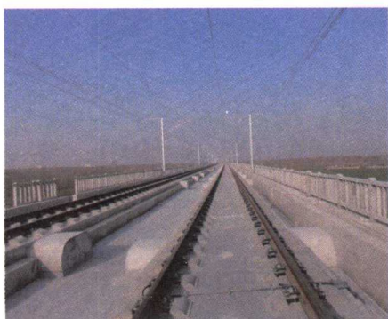
图 1-11 CRTS II 型轨道系统结构
