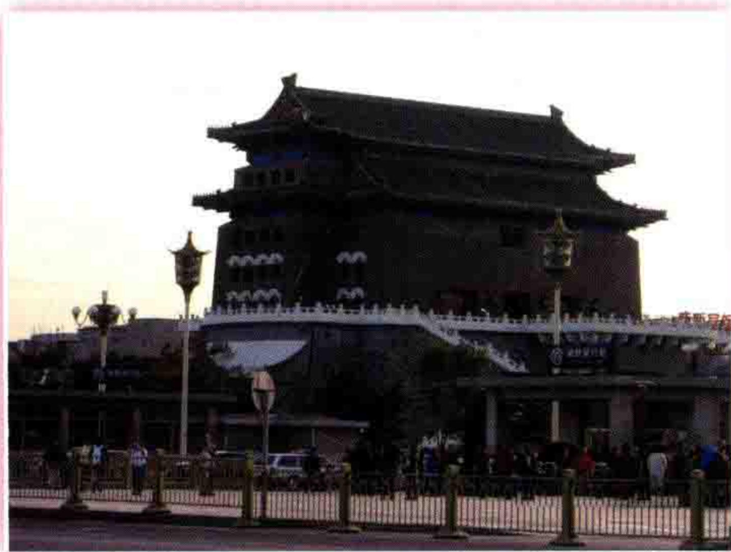
▲ 箭楼（前门地铁站）
