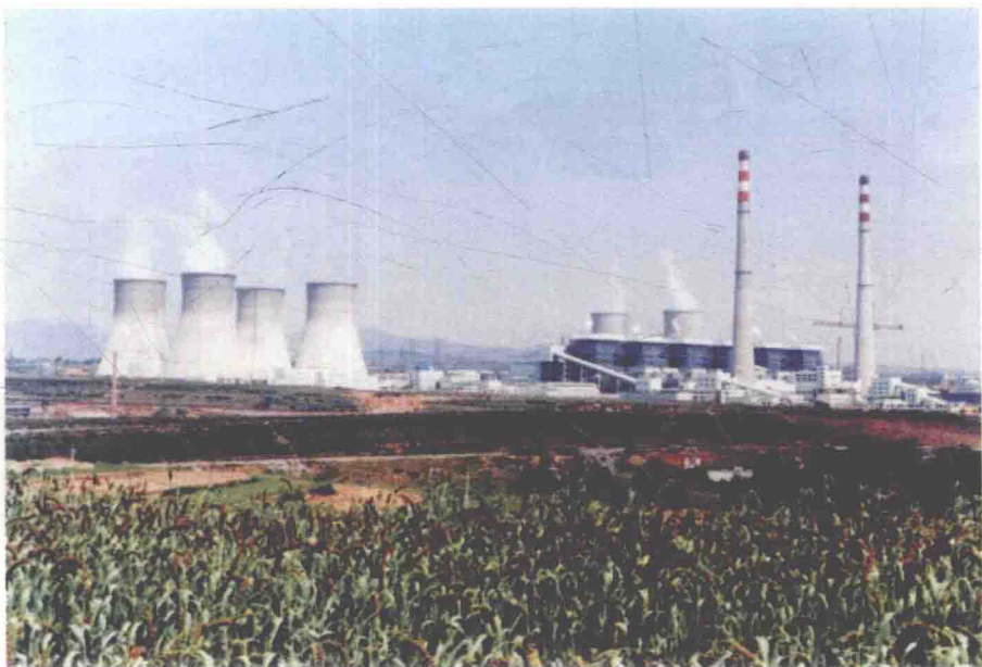
阳城县北留镇的阳城发电厂
