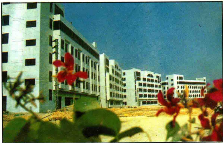
龙丰都田工业区位于惠州市火车站北部，离火车西站 200 米，距惠州市汽车站 3 公里，厂房建筑总面积 22247 平方米。已列入惠州火车站规划开发区范围。工业区前有 20 米宽的公路并靠近宽 24 米的一级公路，环境优美、交通便利，是一个具有综合功能，规模较大的现代化园林式工业区。
