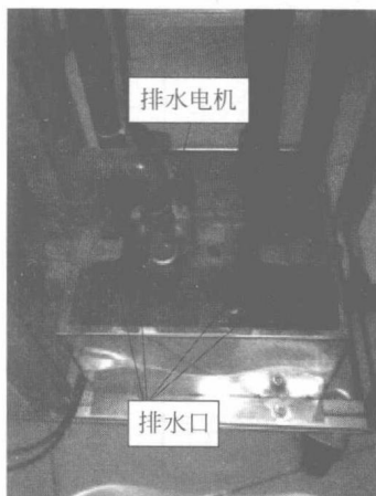
图 1-18 排水电机实物图
