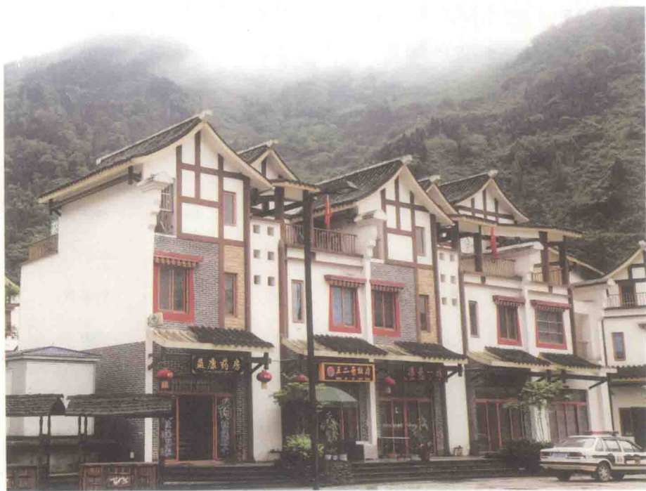
▲ 震后重建的民居
