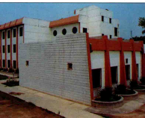
耀县中学综合实验楼
