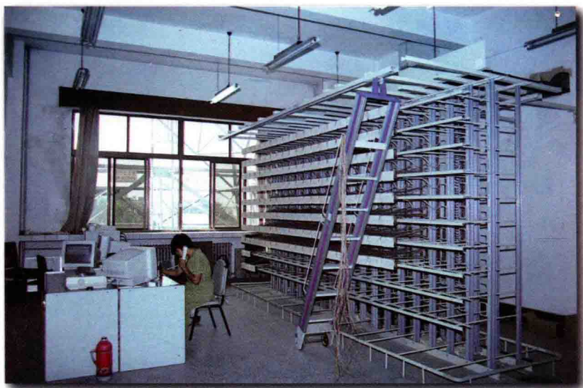
◀ 夏津县邮电局 测量室
