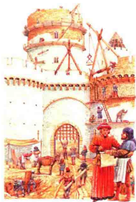
中世纪城堡建设现场
