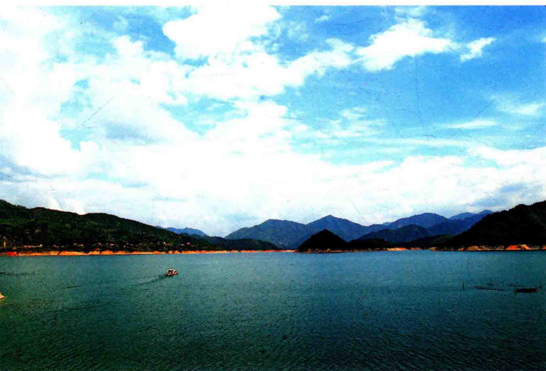
乌溪江水库 (衢州市水利局提供)
