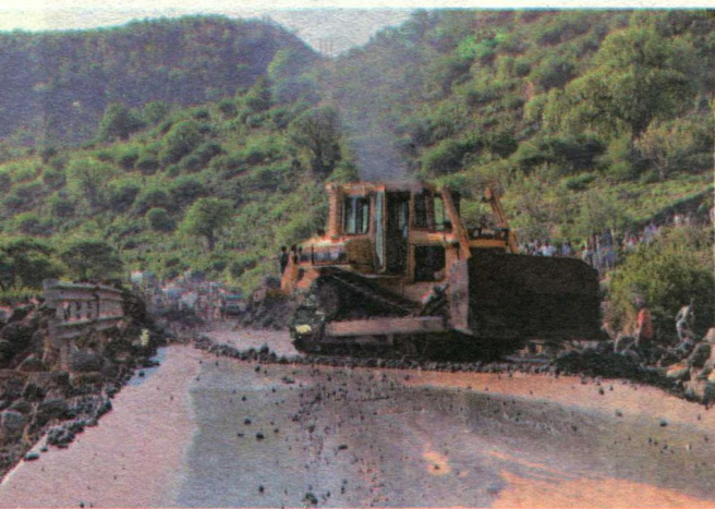
■ 泥石流摧毁道路
