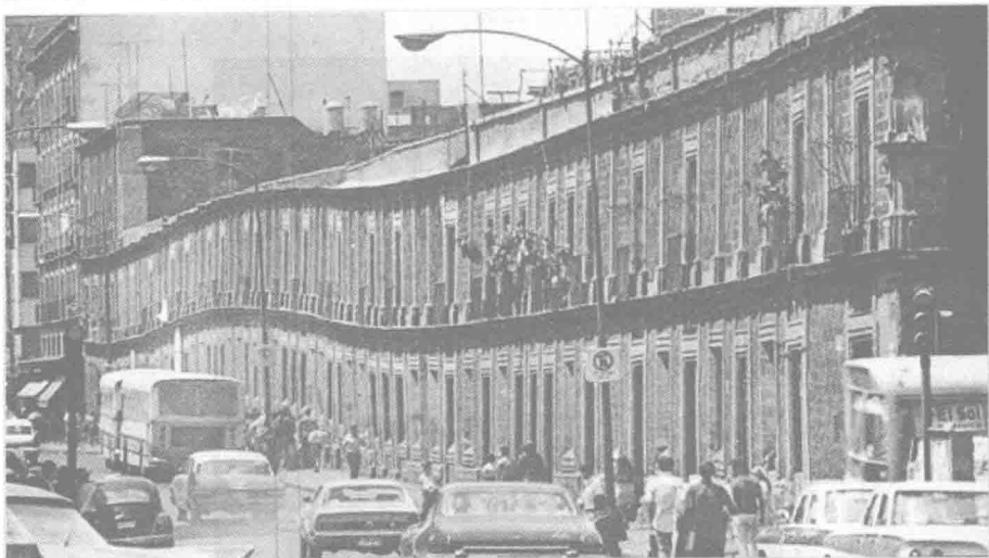
图 0-5 墨西哥城某建筑物不均匀沉降
