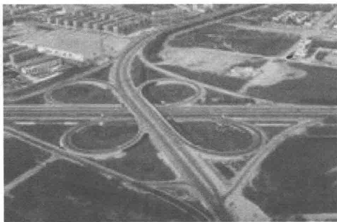
图 1.6 美国新泽西州的双层苜蓿叶式立交桥
