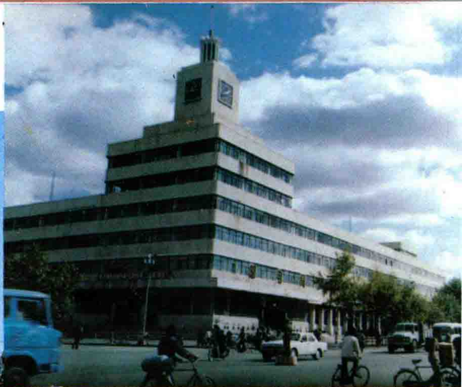
↑ 辽阳邮电大楼
