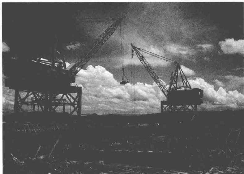
道格拉斯大坝建设工地
