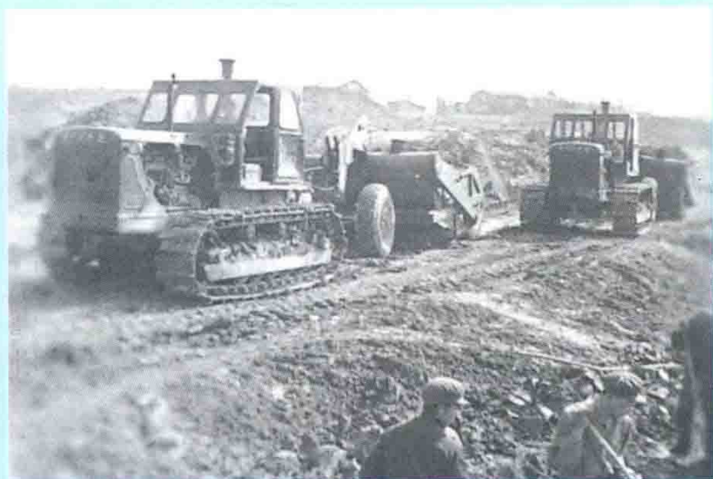
1969 年 11 月 7 日, 建厂工程破土动工
