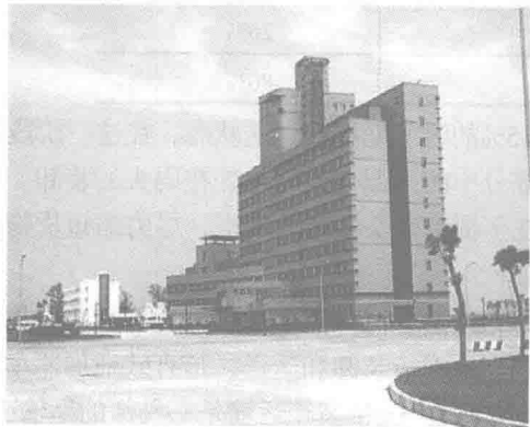
上海外二期码头行政大楼
