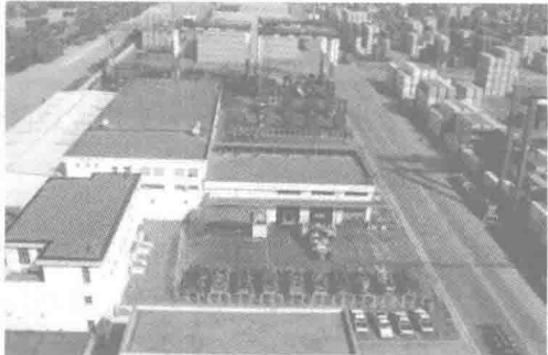
图 1-8 维修车间（深圳蛇口 SCT）
