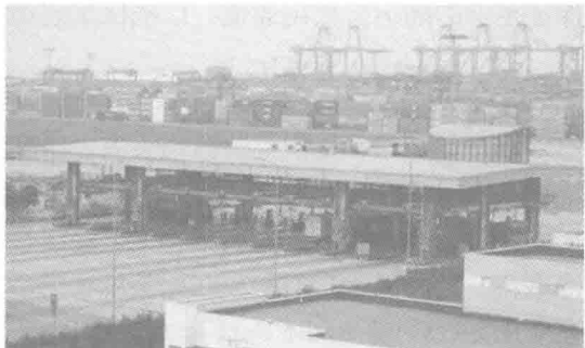
图 1-6 码头闸口（上海外四期 SICT 码头）
