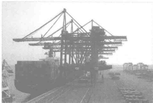
德国汉堡港（海港）Altenwerder 码头前沿
