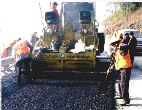
正在施工的铜（鼓）林（家沟）油化路
