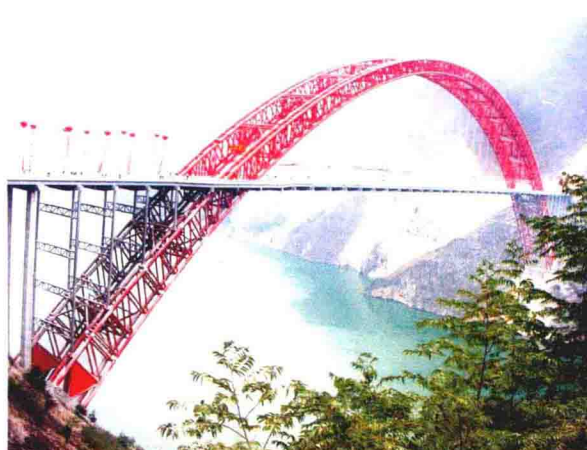
巫山长江大桥全貌
