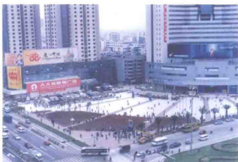
整治一新的麦科特广场（由市政工程总公司负责施工）
