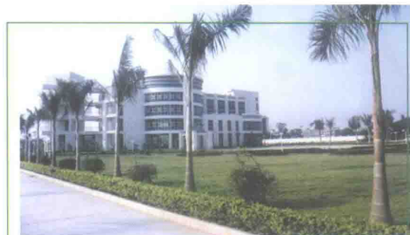
市自来水总公司江北水厂一角
