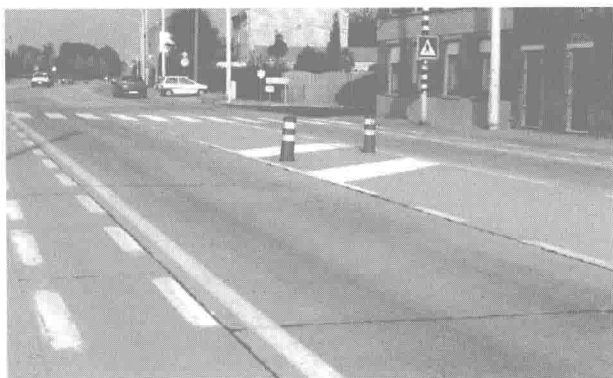
图 1-2 比利时第一条水泥混凝土罩面路面 注:图片拍摄于 2006 年,此时该路面已服务 45 年。
