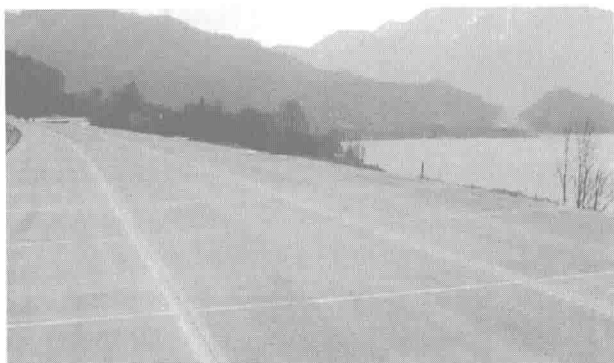
图 1-4 比利时在 E40/A10 公路旧水泥路面上加铺连续配筋混凝土罩面
