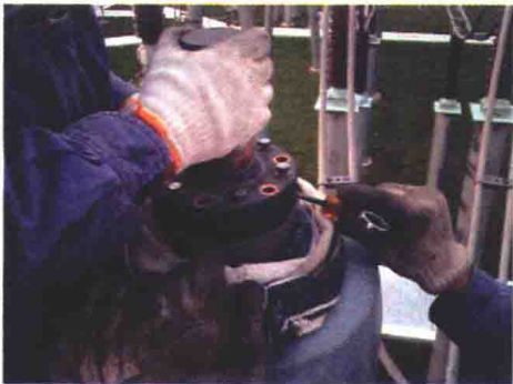
图 2 拆除连接导杆
