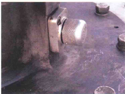
图 2 B 相套管末屏
