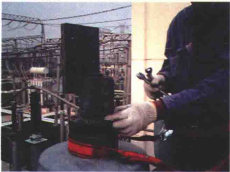
图 1 拆除套管接线板
