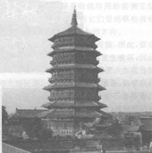
图 0-2 山西应县木塔
