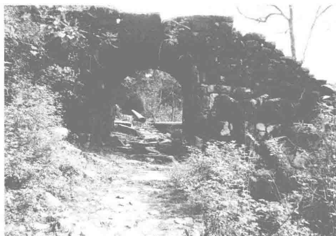
龚滩潭龙古道上的西屏关（运盐要道）
