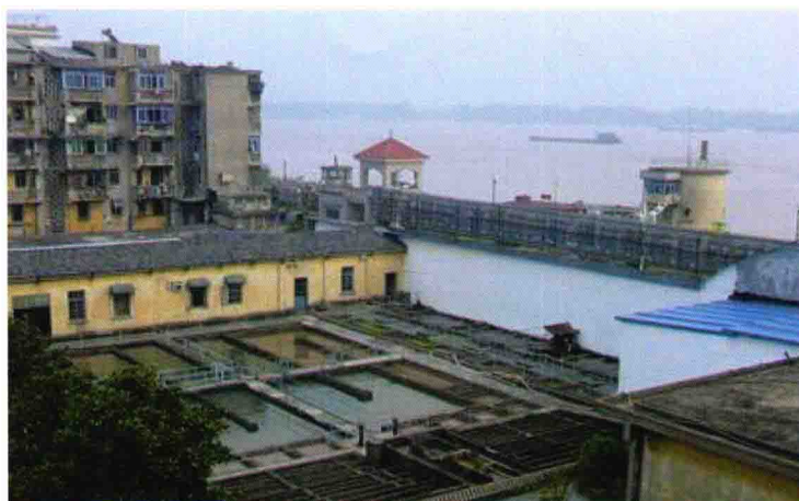
安徽省第一个自来水厂—— 安庆市第一自来水厂
