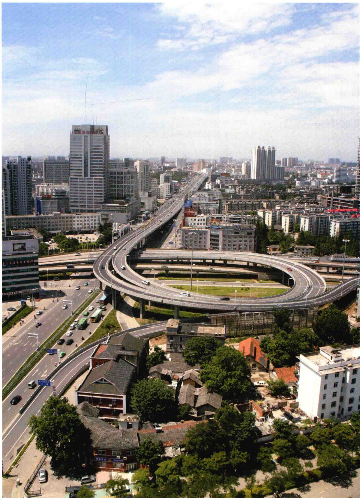
2007 年,安徽省第一条城市高架路——合肥市金寨路高架竣工通车
