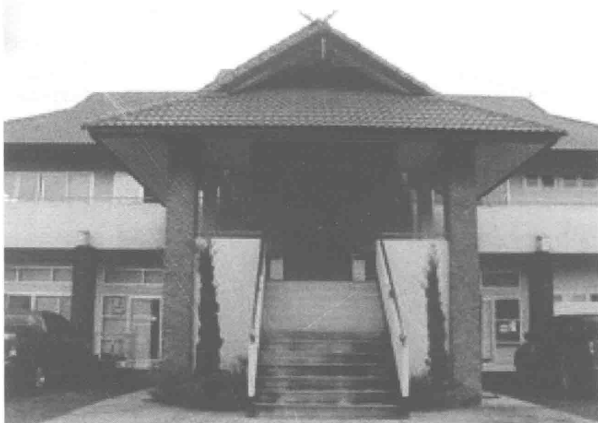
哇威乡办公楼
