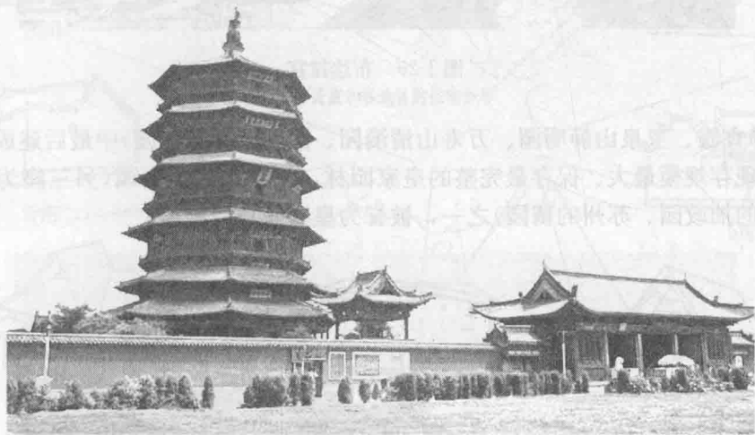
图 1-19 山西应县木塔
